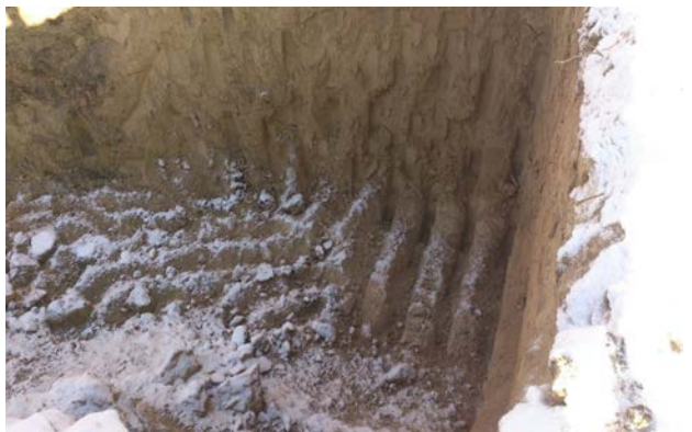
Рис. 2. Особливості будови та стану природних ґрунтів у котловані до облаштування ґрунтової подушки на ділянці т.д.з. 1 і 2
