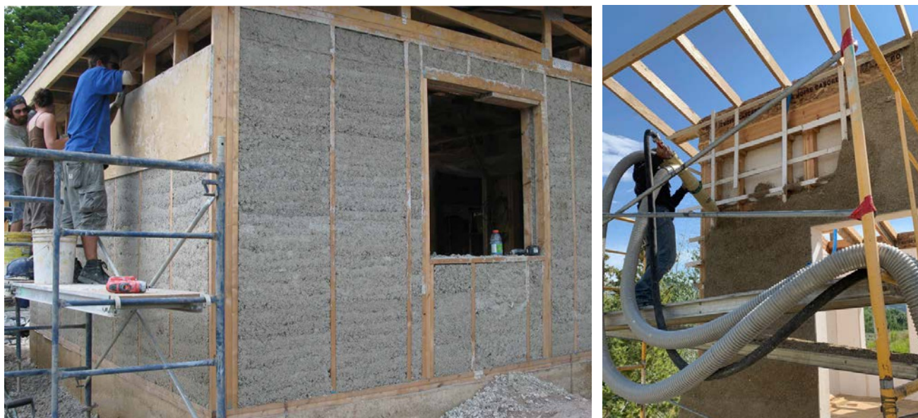
Рис. 2. Використання конопляного бетону змішуванням на будівельному майданчику для влаштування стінових конструкцій
